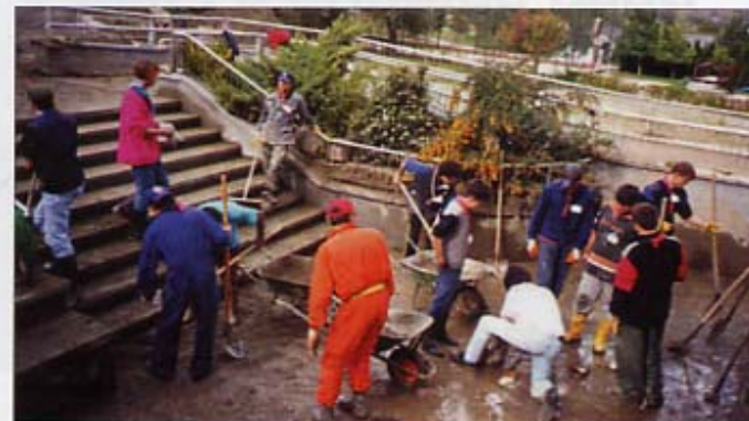
Operazioni di scavo e di pulizia dal fango dopo un'alluvione.
